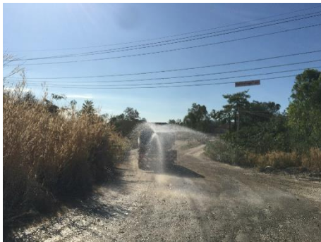
รูปที่ 2-10: การฉีดพรมน้ำบริเวณเส้นทางขนส่งแร่
