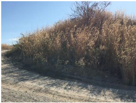
รูปที่ 2-2: การปลูกพืชคลุมดินและไม้ยืนต้นตามแนวคันทำนบดิน
